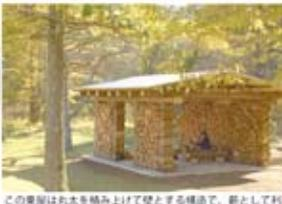
この集材は丸太を積み上げて作る積造で、薪として利用できる。使った分を補充する。
