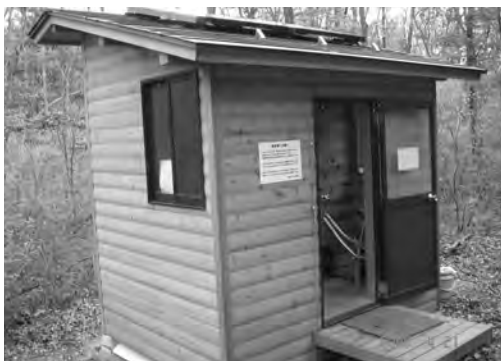
写真1 バイオトイレの外観
