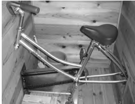
写真4 バイオトイレ内の攪拌のためのペダル
