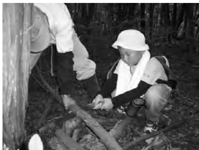
観察路の階段の土止め杭をつくる。
