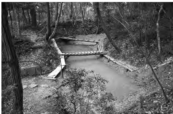
写真2. 完成した水場1
