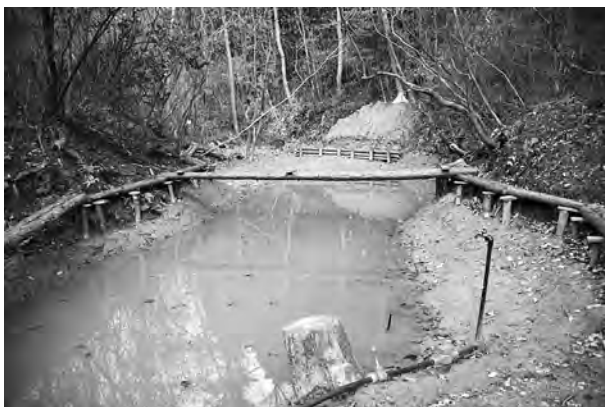
写真4. 完成した水場2
