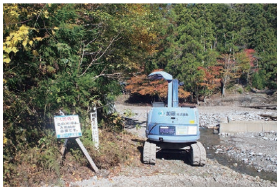
写真5 林道茨川線の延長工事
