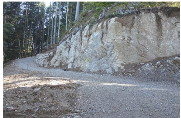
図11. 敷設された林道 土砂流出を防ぐために厚さ60cmの砂利を敷き詰めている。
