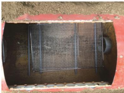
図9 ドラム缶内部：ロストルと呼ばれる鉄筋四本とその上にステンレスの網が2枚載っている。左が焚き口で、右下に煙突の口が見える。
