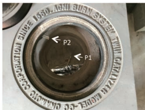
写真3 触媒前後のガス採取場所 注) 触媒を取り外しているときの写真。 P1：触媒前ガス採取場所 P2：触媒後ガス採取場所
