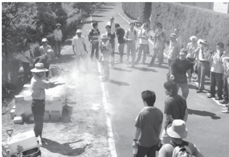
写真4 9月6日他大学参加者の見守る中煙をあげる炭焼き器。煙のコントロールの問題が今後の課題。蓋の継ぎ目、境目を砂で覆うなど金城学院大学からも貴重な助言をもらう。
