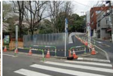
小石川植物園脇の御殿坂一工事後
