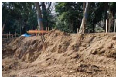
小石川植物園御殿坂側の工事
