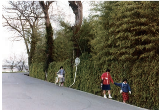
写真2 桂川右岸堤防の笹垣（撮影：大熊）
